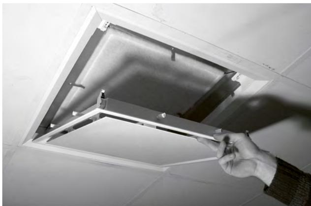
5. Activer le système push-pull en appuyant sur le panneau frontal du diffuseur (diffuseur ouvrant).
