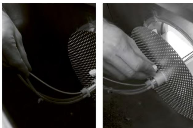
10. Réglage du flux d'air. Faire pivoter la tige de contrôle flexible afin de déplacer la plaque de régulation perforée. Verrouiller le registre MSM dans la position obtenue en serrant la molette.
