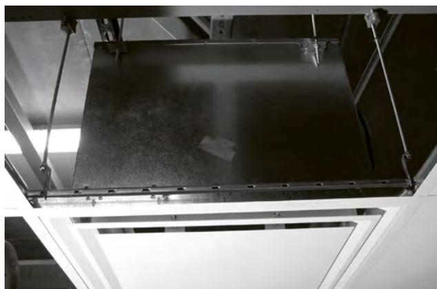
3. Le plénum est installé dans un plafond suspendu avec des tiges filetées et raccordé à la gaine de ventilation. NB : le diffuseur peut être fixé après installation du plénum au plafond sauf pour un montage en faux-plafond indémontable type placo : dans ce cas, prévoir un diffuseur à façade ouvrante.
