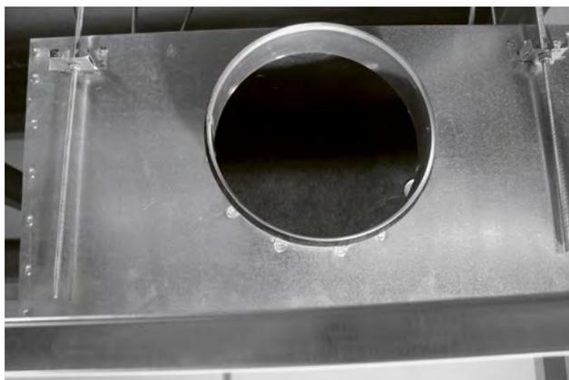
2. Le plénum est installé en retrait (pas à l'arase du plafond) dans un plafond suspendu avec 4 tiges filetées M8 et raccordé à la gaine de ventilation.
