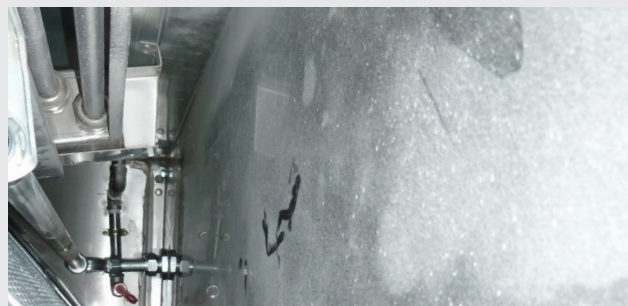
Wygląd wnętrza przestrzeni wyciągowej okapu wyposażonego w lampy UV-C po kilku tygodniach używania.
