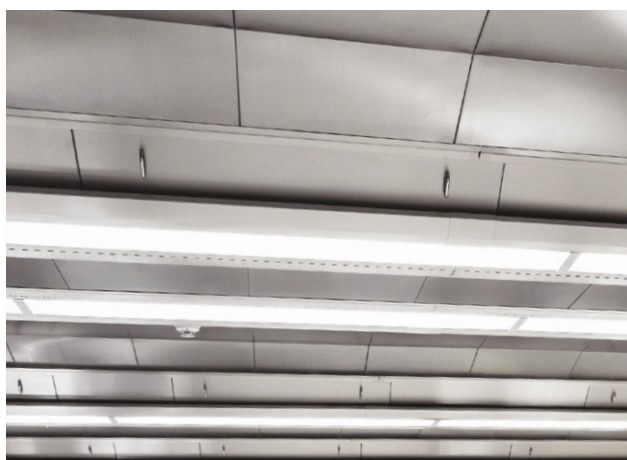
Dwarsdoorsnede van een dubbel plafondplenum met Water Wash- technologie (KCW).
