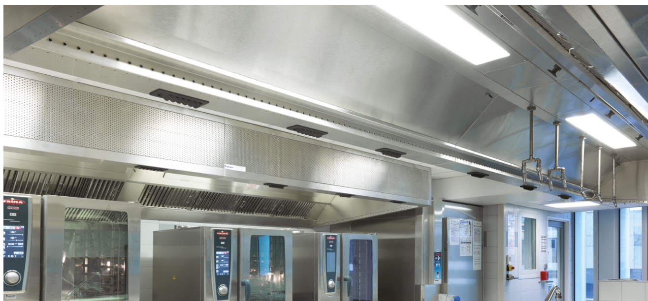
Basalte Building (Paris La Défense, Frankrijk)
