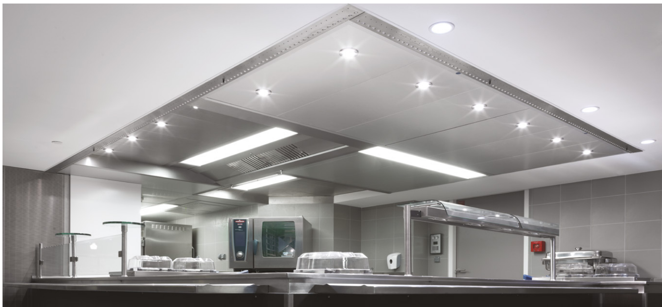
Basalte Building (Paris La Défense, Frankrijk)
