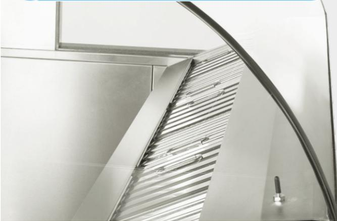
**Eine effiziente Vorabscheidung durch die Kombination von KSA Zyklonabscheidern mit MFA Metall-Gestrickfiltern reduziert die Beladung der nachfolgenden Einwegfilter wesentlich und sorgt so für eine niedrigere Austauschfrequenz.**
